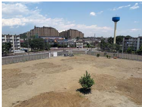
▲工事が進む矢川団地 (建て替え前の号棟から)
