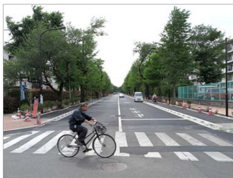
▲減線工事が進むさくら通り
