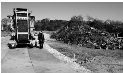
畑だった場所に鉄板が敷かれ、巨大な重機が置かれていました。切り倒された木々が積み上げられ、つぼみを持った梅の枝や柚子の木のついた枝もありました。
